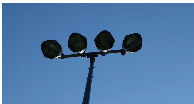
Zdjęcie – oprawy oświetleniowe boiska przeznaczone do wymiany na ledowe.
